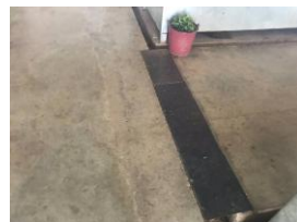
มีรางระบายน้ำ
